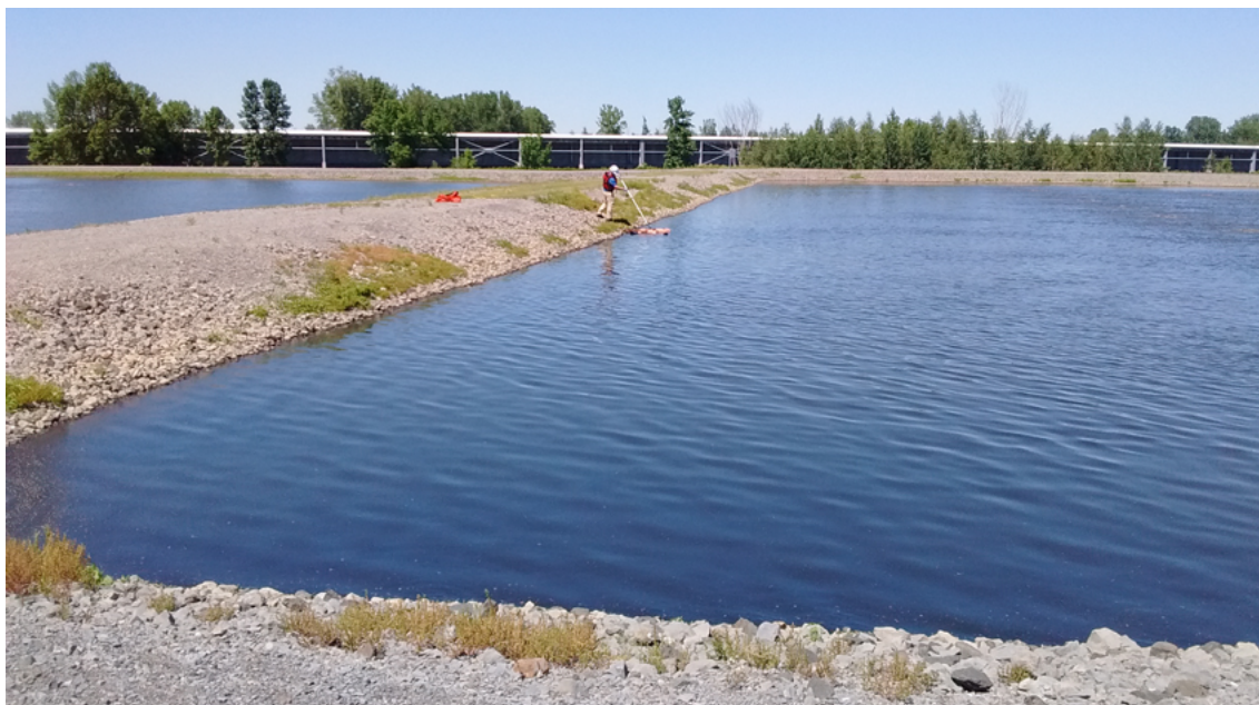
Photo 6.1. Exemple de pente rugueuse avec une pente de 33 % ou 1_v : 3_H
