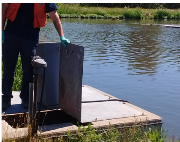
Photo 6.2. Exemple d'un déversoir avec paroi verticale
