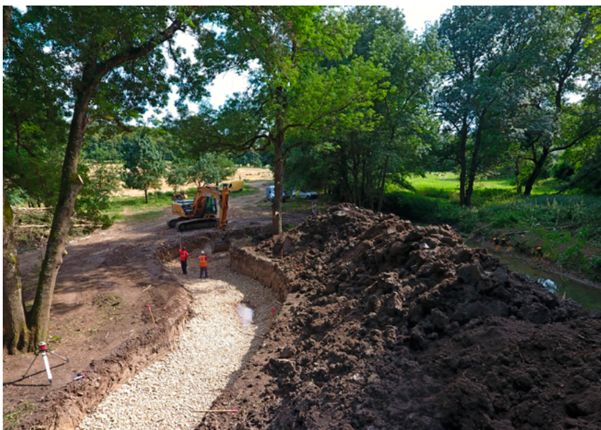
Recharge sédimentaire dans le cadre de la réalisation d'une dérivation de cours d'eau. À noter le risque de départ de fines vers le milieu aquatique à cause du positionnement des déblais de terre nue Crédits : Michel Bramard / OFB
