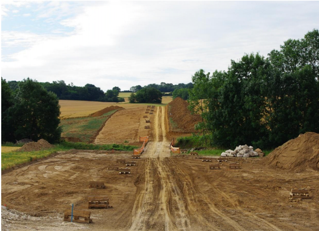
Exemple de création de pistes de chantier dans le cadre d'un franchissement provisoire de cours d'eau Crédits : Thomas Schwab / AFB
