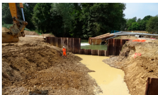
Batardeau de palplanches battues (vue frontale de la zone de chantier) Crédits : GRENA Consultant
