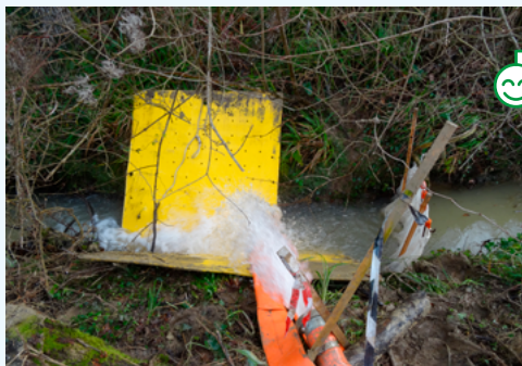
Point de rejet protégé au moyen de plaques métalliques Crédits : GRENA Consultant
