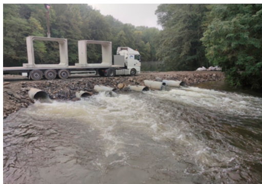
Passage sur piste dans une configuration de type estacade Crédits : GRENA Consultant
