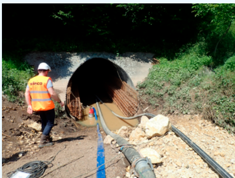
Chantier sous dérivation par pompage hors aléa climatique
