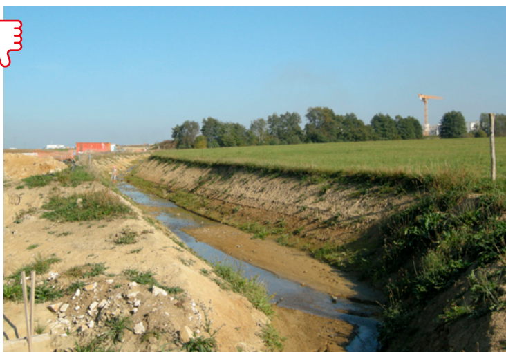
Dérivation provisoire mal réalisée. Le lit mineur est trop large, berges abruptes et sans végétation. Crédits : Marc Gigueux / Cerema
