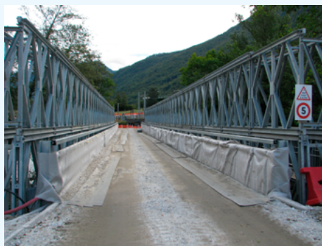
Protection latérale de la passerelle pour éviter les projections de boue vers le cours d'eau Crédits : Nicolas Georges / Cerema
