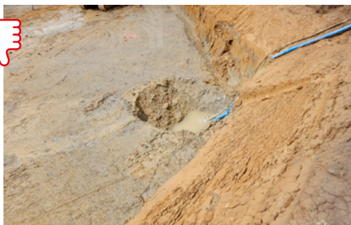
Pompage d'eau chargée en MES par des crépines non protégées en fond de fosse Crédits : Marc Gigleux / Cerema
