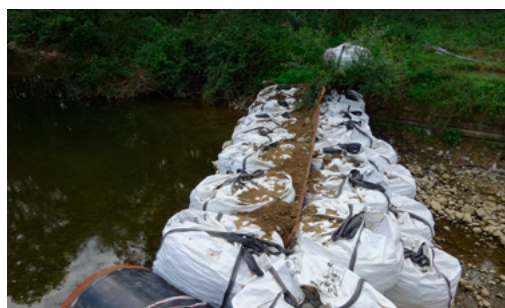
Batardeau composite associant plaque guillotine et big bags (vue latérale de la rive) Crédits : GRENA Consultant
