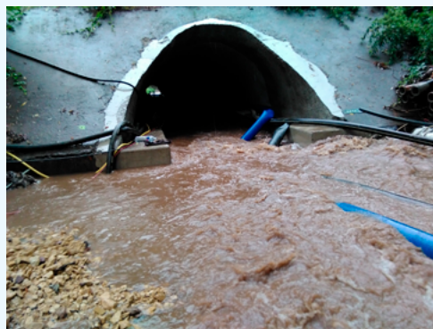
Chantier sous dérivation submergé du fait d'une capacité de pompage insuffisante face à un orage violent.
