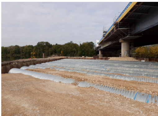
Estacade sur remblais avec des buses pour maintenir la continuité hydraulique Crédits : Thomas Schwab / Cerema
