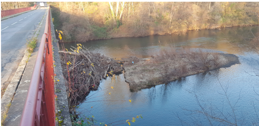
Embâcle à l'amont d'un pont sur l'Agout avec accumulation de débris végétaux et de sédiments Sources : Conseil départemental du Tarn
