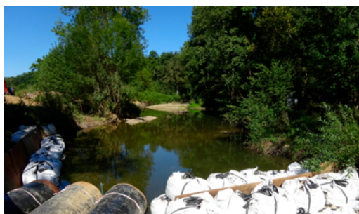
Batardeau composite associant plaque guillotine et big bags (vue frontale de la zone de chantier) Crédits : GRENA Consultant
