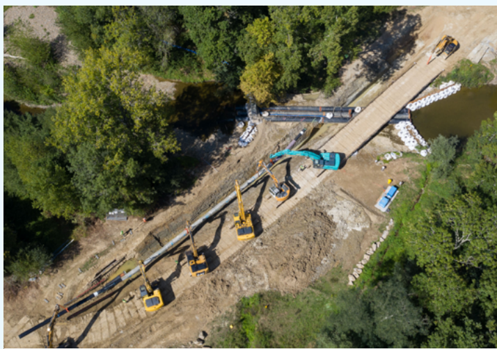
Enfouissement d'une canalisation gazière en souille sous le lit du Luy de Béarn Crédits : Chantier Teréga / Luc Hauteceur
