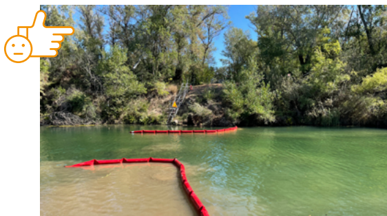
Rideau de turbidité confinant les eaux de chantier chargées en matières en suspension (MES) Crédits : GRENA Consultant
