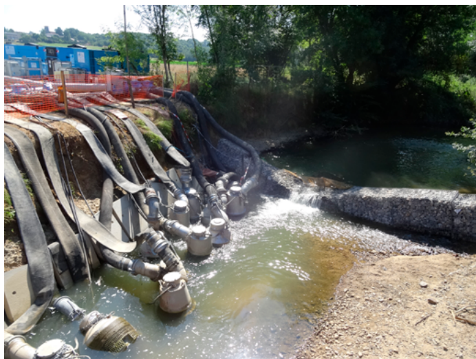
Dispositif de pompage sur une zone de chantier à l'aval d'un batardeau Crédits : GRENA Consultant
