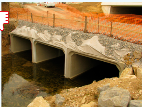
Sur ce passage, les dalots ne sont pas enterrés à 30 cm de profondeur sous le lit du cours d'eau. Crédits : Nicolas Georges / Cerema
