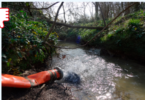
Point de rejet non protégé avec risque érosif sur le substrat du lit du cours d'eau Crédits : GRENA Consultant
