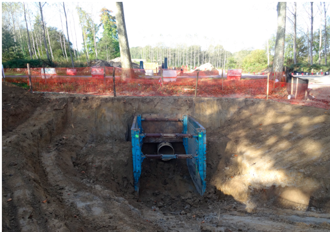
Puits d'un chantier au microtunnelier Crédits : GRENA Consultant
