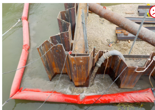
Le rideau de turbidité est inefficace car le rejet est trop proche de la ligne de flotteurs du rideau et déborde par-dessus Crédits : Thomas Schwab / AFB
