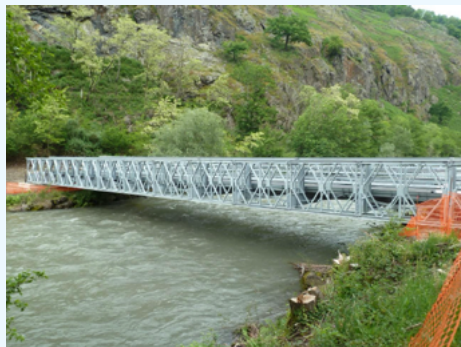
Passerelle métallique avec appui en béton en arrière des berges, pour le passage d'engins Crédits : Nicolas Georges / Cerema
