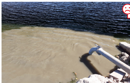
Rejet d'eau chargée en MES. Un traitement par décantation ou infiltration aurait été nécessaire. Crédits : Thomas Schwab / Cerema
