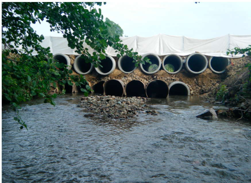
Passage sur un ouvrage mixte de gaines et de buses. Résistera-t-il en cas de crue ? Crédits : Frédéric Fromager / OFB
