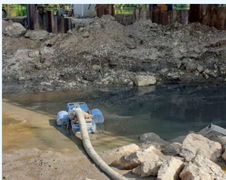
Système de crépine flottant avec un réglage de niveau empêchant l'aspiration de la boue en fond de fosse.
