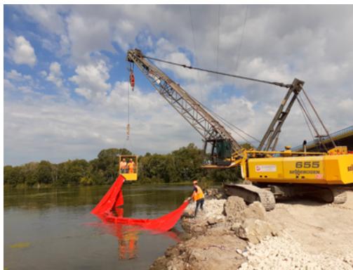
Mise en place d'un rideau de turbidité nécessitant une grue Crédits : Thomas Schwab / Cerema
