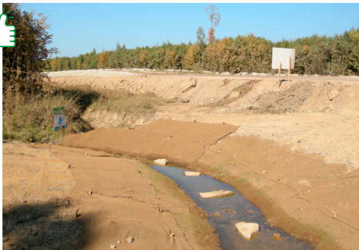
Dérivation provisoire plutôt bien réalisée, un lit mineur d'étiage, une granulométrie variée (cailloux/pierres/blocs), des berges en pente douce et protégée par un géotextile végétalisé. Crédits : Marc Gigueux / Cerema
