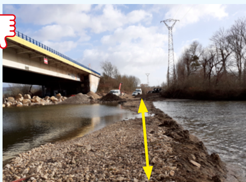
Batardeau aval quasi noyé Exemples de batardeaux sous-dimensionnés Crédits : Thomas Schwab / Cerema
