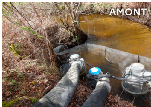
Enceinte de filet pour éviter l'aspiration de la faune aquatique.
