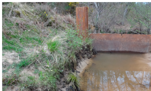
Batardeau avec plaque guillotine enfoncée (vue frontale de la zone de chantier) Crédits : GRENA Consultant
