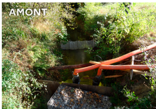
Le tronçon de cours d'eau est barré en amont par un filet et les crépines sont positionnées devant le batardeau en plaque et encore placées dans une enceinte de filet (en jaune).
