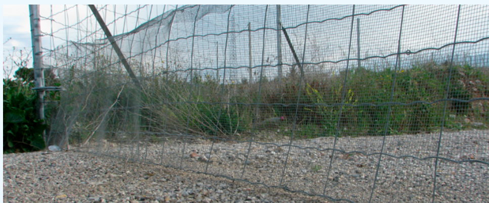
Grillage anti-intrusion pour la petite faune au niveau d'un portail d'accès au chantier Crédits : Nicolas Georges / Cerema
