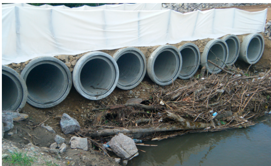
Embâcles formés à l'amont d'un ouvrage provisoire de franchissement Crédits : Frédéric Fromager / OFB
