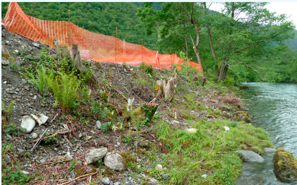
Maintien des souches pour permettre la reprise des arbres à partir du collet Crédits : Nicolas Georges / Cerema
